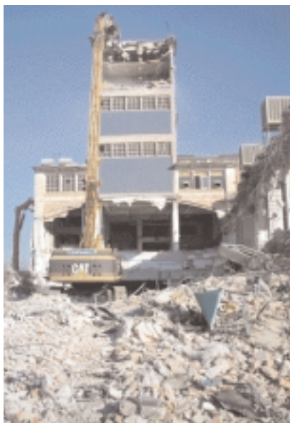
FIGURA 3.- LAS ESTRUCTURAS MÁS ALTAS FUERON DEMOLIDAS CON LA ACCIÓN DE UNA EXCAVADORA DE BRAZO LARGO Y CON DEMOLEDOR PRIMARIO.
