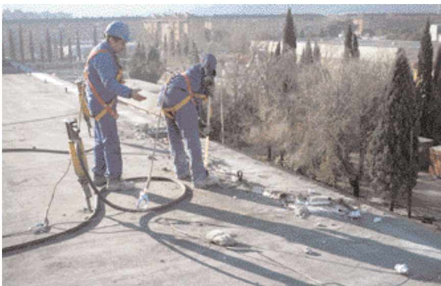
FIGURA 4.- CIERTAS ZONAS FUERON TRATADAS PREVIAMENTE CON HERRAMIENTAS NEUMÁTICAS.
