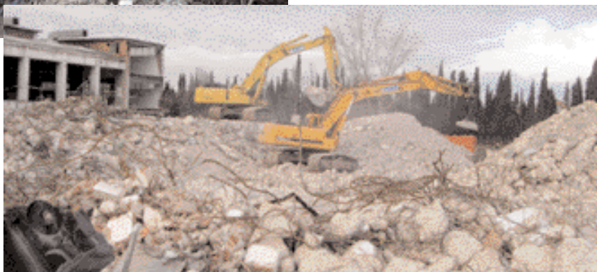
FIGURA 7.- EN FUNCIÓN DE LA NATURALEZA DE LOS DIFERENTES RESIDUOS, ÉSTOS SE FUERON APILANDO EN ZONAS DETERMINADAS.
