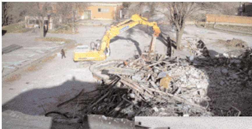
FIGURA 6.- LAS ESTRUCTURAS METÁLICAS FUERON TRATADAS CON UNA EXCAVADORA CON CIZALLA.
